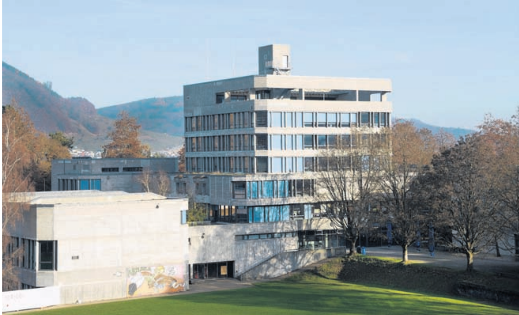
Unerschütterlich. Nach einer fünf Millionen Franken teuren Sanierung ist das Gymnasium Liestal nun erdbebensicher. Foto Elena Monti
